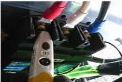
発電機の急始動を防ぐ為に安全処置、検電を行います
